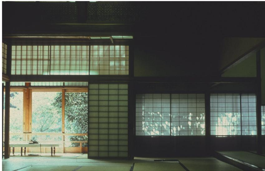
nendem, weißem Papier bespannt sind. Sie heißen Shoji. Anstatt Mauern mit Löchern haben wir leichteste, verschieb- und herausnehmbare Rahmen, die das tragende, sichtbare Holzskelett ausfüllen, das in seinen Dimensionen auf das Äußerste reduziert wirkt wie ein elegantes Stahlskelett. Am dritten Bau der Prinzenvilla Katsura von 1660 verlaufen die Shoji Wände über Eck. Das Gebäude wirkt wie eine große Laterne, die nach allen Seiten ein sanftes Licht ausbreitet.
