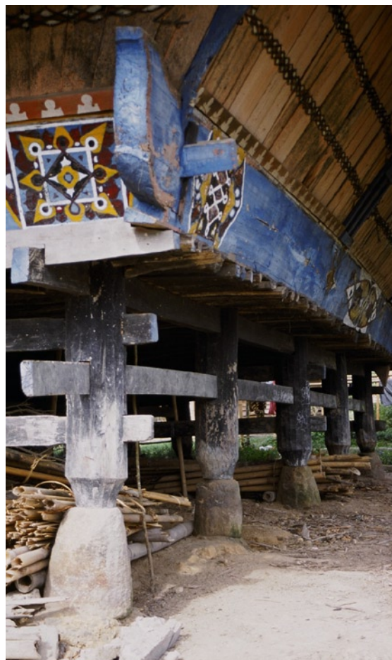
Abb. 3. Die Skelettkonstruktion des Unterbaus eines Wohnhauses der Karo-Batak mit den deutlich zur Schau gestellten bautechnischen Details der Schlitz-Zapfenverbindungen und der Basissteine, die das Verrotten der Steher verhindern sollen. (Lingga)
