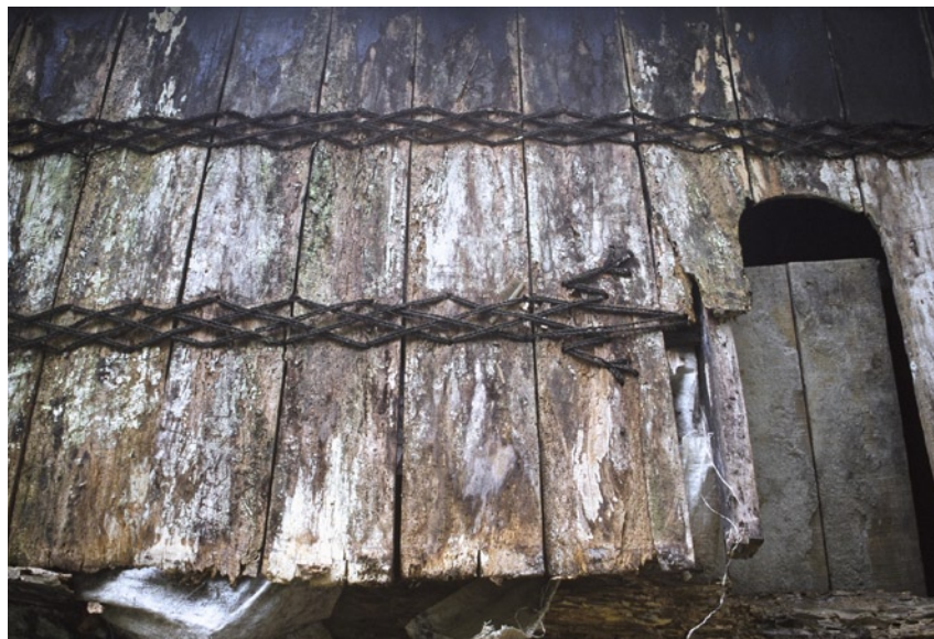
Abb. 4. Konstruktive Details der Wandzone als Dekor: Plankenverschnürungen in Form von Eidechsen an einem Wohnhaus der Karo-Batak. (Peceren)
