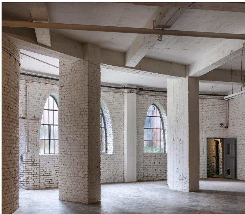
Abb. 6–7 Der zentral angelegte Pfarrsaal im Untergeschoss wurde durch einen Estrichboden nutzbar gemacht, eine zwischenzeitlich projektierte Behandlung der Oberflächen blieb ohne Ausführung. Die Räume des östlichen Jugendheimes blieben als Rohbau der ersten Bauphase erhalten. Als die Entscheidung getroffen war, diese Räume nicht zu nutzen, wurden die Fensteröffnungen mit Ziegelmauerwerk verschlossen. Fotos: © Reinhard Görner, Berlin
