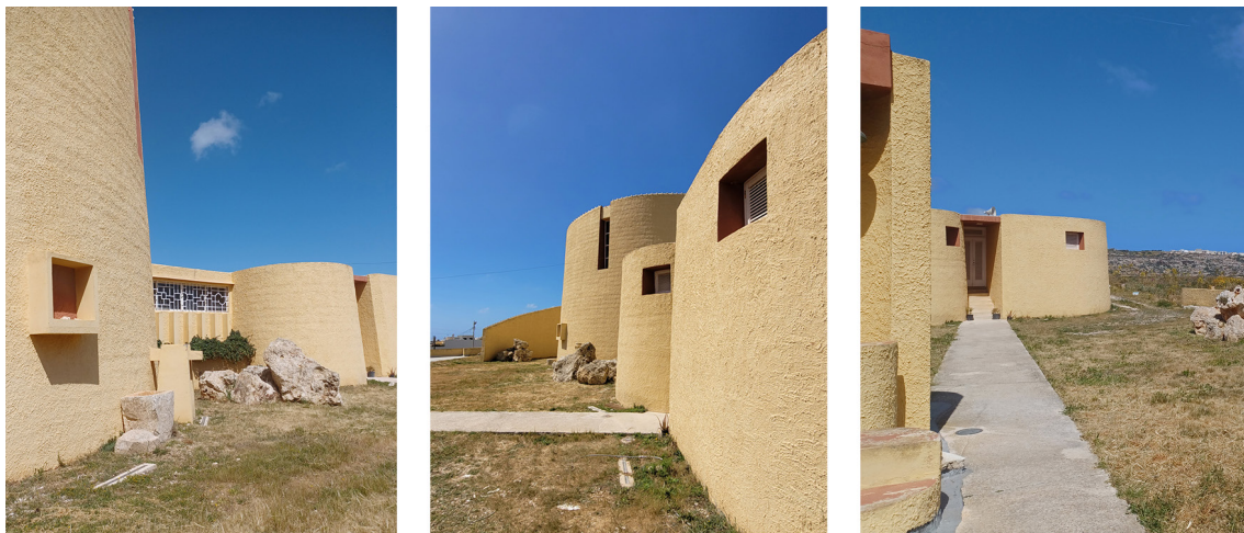
Abb. 17 Der von Weitem als kraftvolle Großform angelegte Komplex zeigt sich bei näherer Betrachtung als detailliert entworfen. Die Fenstergitter wiederholen das Motiv der gegeneinander versetzten Halbkreise des Grundrisses (links). Es gibt Staffageelemente wie Nischen, einen Wasserspeier und Findlinge. Die Umfassungsmauer ist im Osten unterbrochen: Hier fließt die Landschaft auf den zuntir (rechts); mitunter ziehen Schafherden hindurch. Fotos: Verena Hake, 2023.
