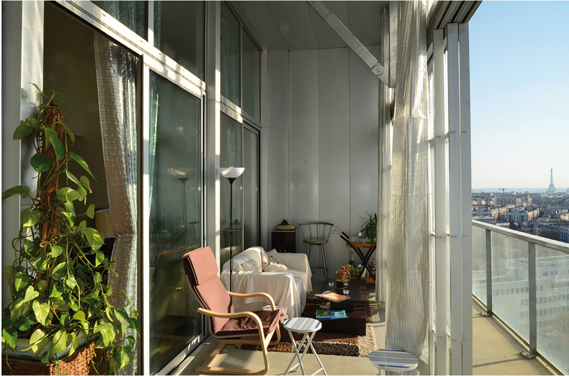
Abb. 17. Transformation der Tour Bois-le-prêtre. Paris. Druot, Lacaton & Vassal 2006-11. Wohnraumerweiterung durch Wintergärten als vorgestellte Fassade. 2011. Foto: Frédéric Druot. Quelle: lacatonvassal.
