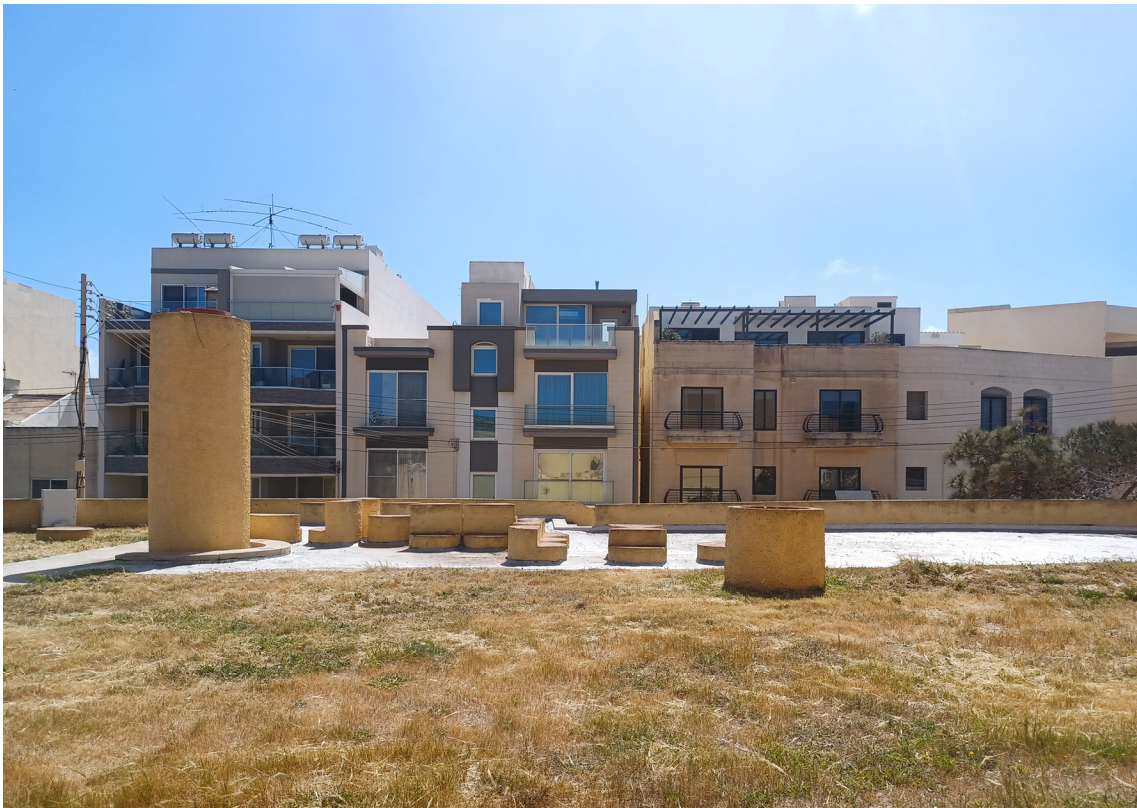
Abb. 23 Südlich des Kirchenkomplexes wurden in unmittelbarer Nachbarschaft mehrgeschossige Wohnbauten errichtet. Diese achten weder das sakrale Ensemble noch die umgebende Landschaft. Das einst in alle Richtungen ausstrahlende symbiotische Verhältnis der Kirche mit ihrer Umgebung ist massiv beschädigt, ja zerstört worden. Foto: Verena Hake, 2023.
