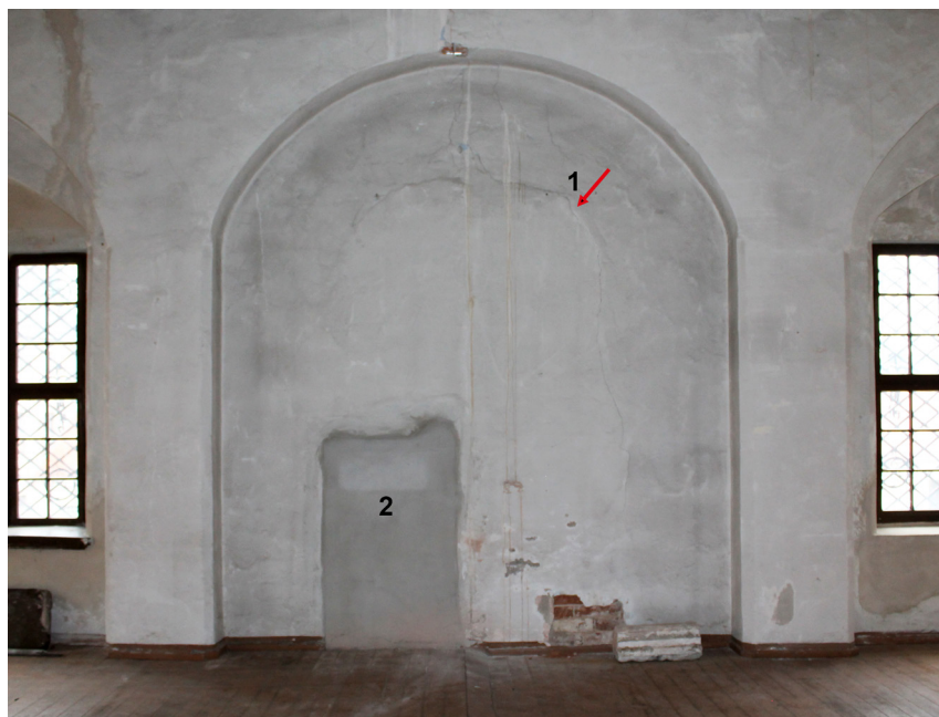
Abb. 11: Blick auf die nördliche Wand mit den relevanten Baubefunden. 1: Baubefund aus der Renaissance: zugesetzte bogenförmige Öffnung mit ehemaligem Zugang zur Außentreppe. 2: Baubefund aus der NS-Zeit: zugesetzte Türöffnung als ehemaliger Zugang zum Maschinengewehrstand. Sammlung Gedenkstätte KZ Lichtenburg Prettin, 2023, bearbeitet von Anke Fissabre.
