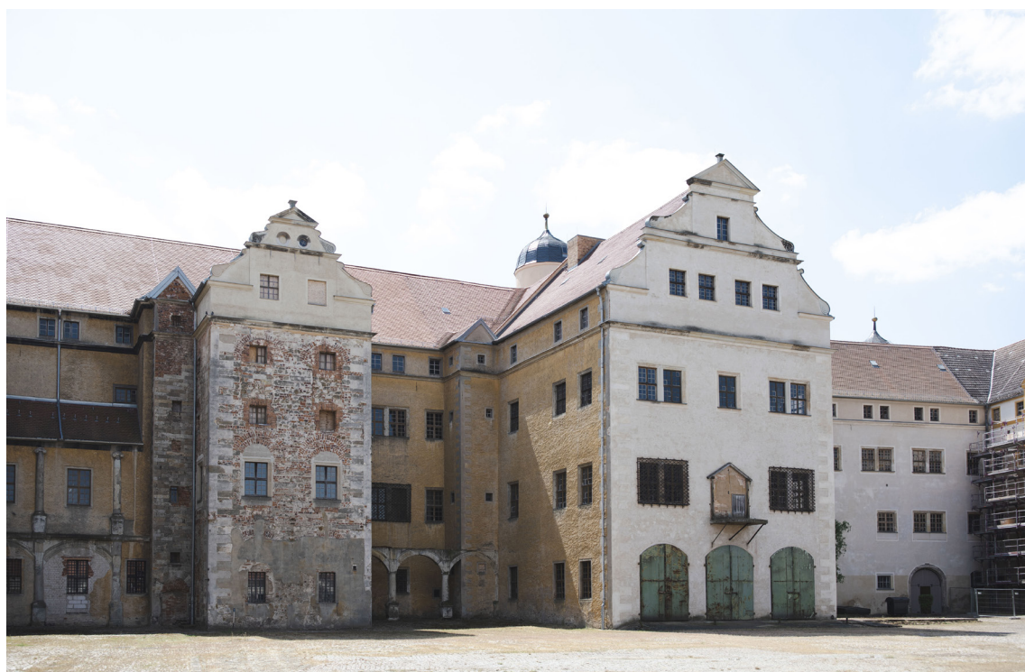
Abb. 14: Blick auf die heutige Fassade mit den baulichen Überresten des Maschinengewehrstandes. Links im Bild sind die baulichen Reste der zweigeschossigen, offenen Loggien aus der Zeit der Renaissance zu sehen, 2023. Michel Winter für die Gedenkstätte KZ Lichtenburg Prettin.
