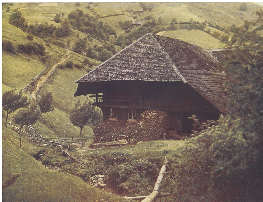
Abb. 11. Hauptmerkmal des Schwarzwaldhauses sind die seitlich weit herabgezogenen Dachflächen, die eine verringerte Angriffsfläche für Windlasten aufweisen. Der große Dachüberstand auf der Giebelseite reflektiert abstrahlende Wärme und verschattet im Sommer die dunklen Hauswände (siehe dazu auch Abb. 15). 1904. Quelle: Rijksmuseum Amsterdam.
