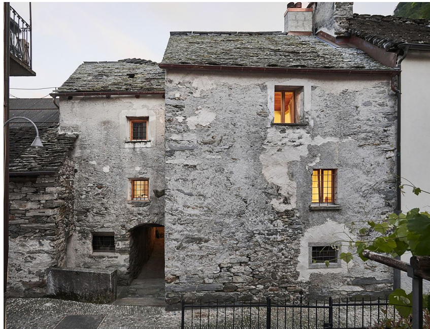
Abb. 8. Tessiner Steinhaus aus lokalem Gneis. Flache Steinplatten zur Dacheindeckung werden sorgfältig angeordnet, um eine wetterfeste und langlebige Abdeckung zu bieten. 2021. Foto: Antonio Pisoni.
