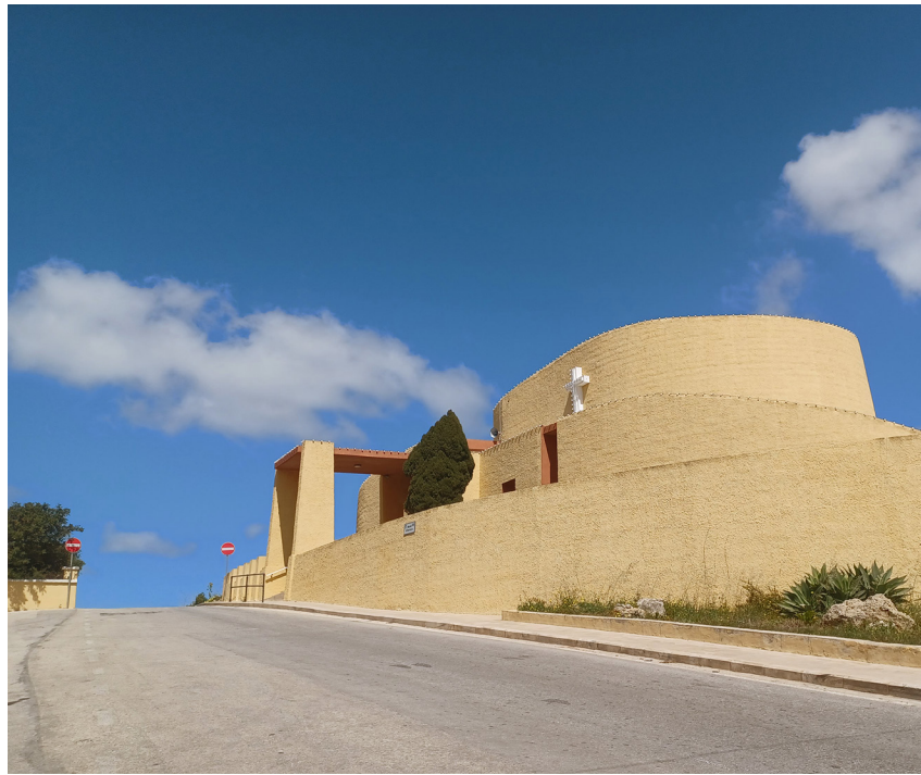
Abb. 7 Antlitz der Kirche von Südwesten. Ein offener Eingangskorridor mit Trilith-Motiv führt zum westlichen der beiden Ein- und Ausgänge der Kirche. Die kurvierte Stützmauer, identisch materialisiert wie das Kirchengebäude selbst, gewinnt gen Süden sukzessive an Höhe. Foto: Verena Hake, 2023.
