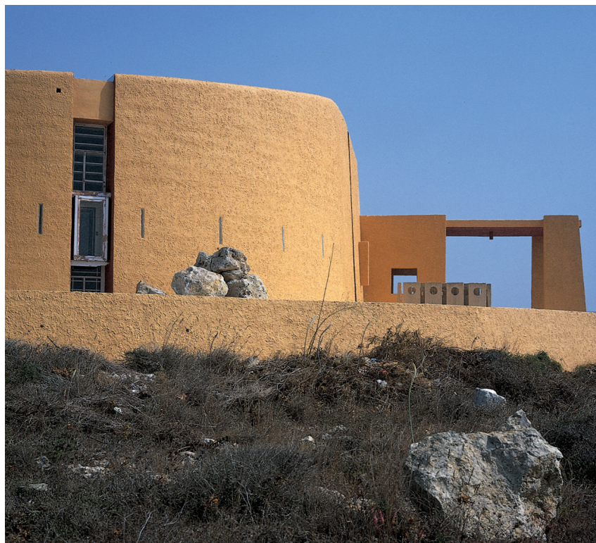
Abb. 4 Antlitz der Kirche von Norden. Sie wirkt wie aus Lehm geformt, ist tatsächlich aber mit einem groben Putz überzogen. Seine Farbe erinnert an den globigerina -Kalkstein, der das architektonische Gesicht der ganzen Insel bestimmt. Eine niedrige Mauer trennt den sakralen vom weltlichen Bereich. Foto: Richard England*, o.J.
