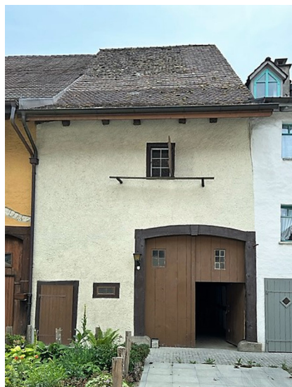
Abb. 15. Rückfassade zur Mühlen-gasse. Foto: Autorin.
