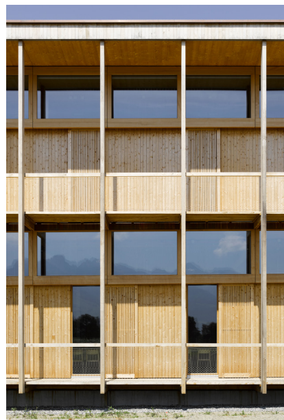
Abb. 18-19. Landwirtschaftliches Zentrum in Salez. Andy Senn Architektur 2017-19. Die Dachhaut wurde über die Hauptkubatur hinausgezogen und dient dem Witterungsschutz. Konstruktiv verwandt mit dem Balkon, vereint der Laubengang den schützenden sowie thermischen Charakter einer Pufferzone. 2019. Foto: Seraina Wirz (links). Der Arkadengang spendet Schatten, schützt vor direkter Sonneneinstrahlung und Regen. Durch die natürliche Luftzirkulation und den Temperatenausgleich reguliert er das urbane Mikroklima. Vigevano 2018. Foto: Roberto Crepaldi (rechts).
