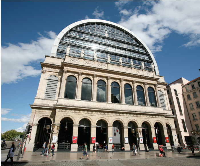
Abb. 2, 3. Ansicht der von Jean Nouvel umgebauten Oper von Lyon, Foto: Ludovic Courtès (links), Nächtlicher Blick auf die von Jean Nouvel umgebaute Oper von Lyon durch die Arkaden des Hôtel de Ville von Lyon, Foto: Philippe Ruault (rechts).
