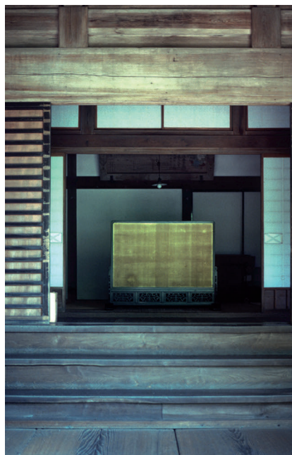
Aufgeschobene Türen und "Geisterwand" an einem japanischen Tempel. Foto © Manfred Speidel.
