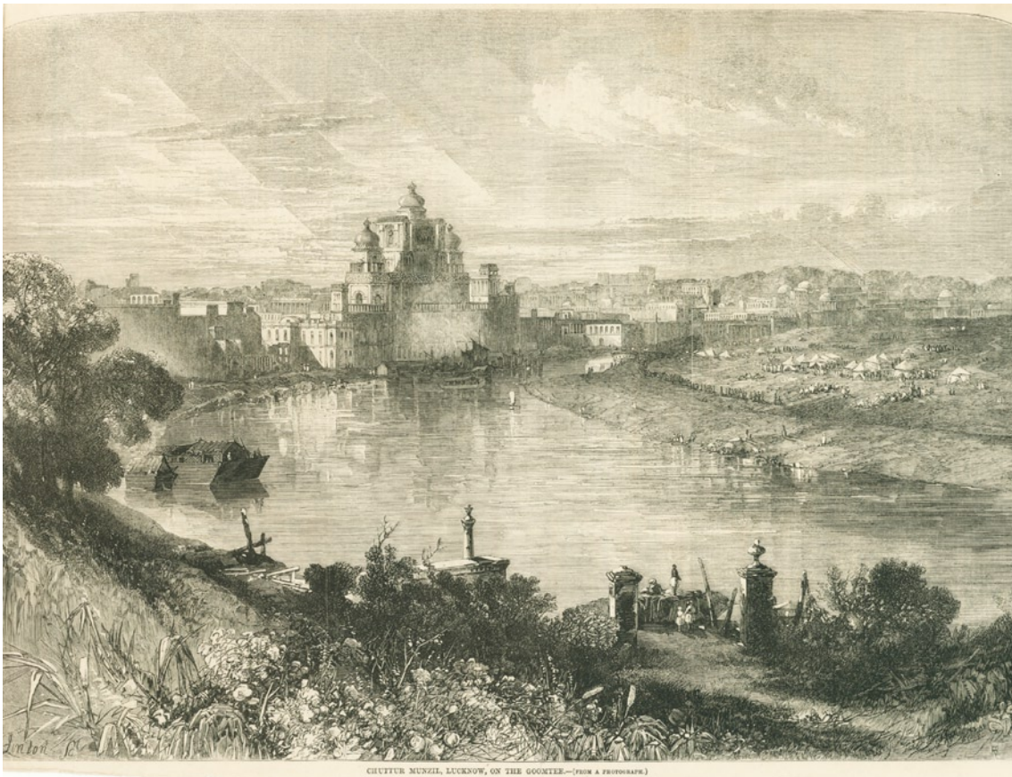
Abb. 19. "Chatur Manzil, Lucknow, on the Gomtee. (from a Photograph)" – Kupferstich aus der Illustrated Times , 17. April 1858. Das Bild zeigt die schmale abgestaffelte Kubatur des Palastes.
