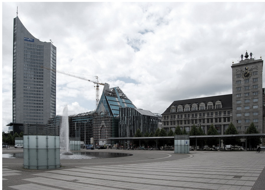
Augustusplatz, "City-Hochhaus" und Neubau des Universitäts-Hauptgebäudes. Juni 2010. (Foto: Stahlbauer. Quelle: flickr).
