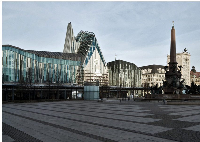
Der Augustusplatz im November 2011. Neubau des Hauptgebäudes der Universität in Erinnerung an die Kubatur der zerstörten Paulinerkirche und des Augusteums. Architekt Erick van Egeraat. (Foto: Templermeister. Quelle: wikimedia).
