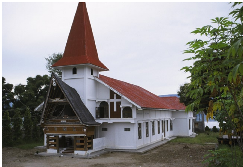
Abb. 17. Mit dem Modell eines halbierten traditionellen Toba-Wohnhauses als Eingang erhält die in der obligatorischer Stahlbetonskelettkonstruktion errichtete indonesische Kirche den ersehnten regionalen Touch.
