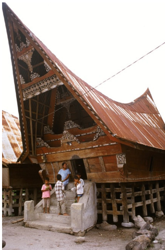
Abb. 10. Zur Aufwertung der Eingangssituation werden den traditionellen Wohnhäusern der Toba-Batak heute oft völlig deplaciert wirkende Freitreppen aus massivem Beton vorgelagert (Samosir).
