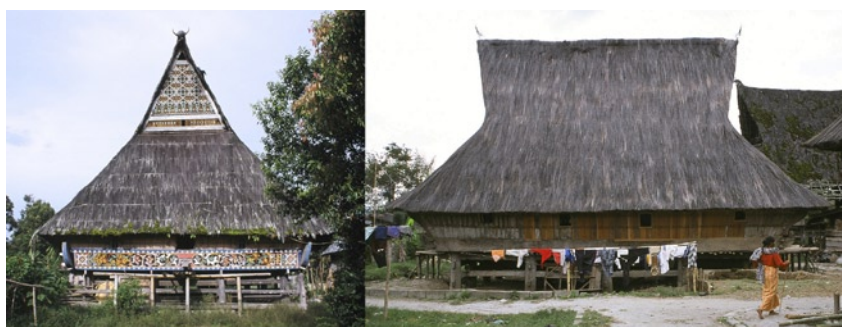
Abb. 6. Die markante Dachform des Wohnhauses der Karo-Batak, gezeigt in ihren unterschiedlichen Schauseiten der Frontalansicht (links) und Seitenansicht (rechts). (Lingga und Barusjahe)
