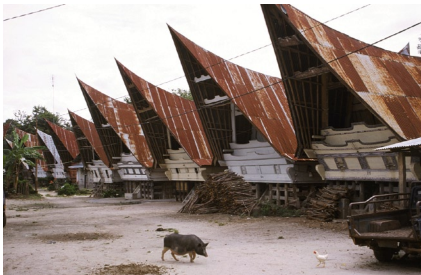
Abb. 5. Die markante Gestalt der sattelförmigen Dächer mit ihren weit vorkragenden Giebeln verleiht den Dorfplätzen der Toba-Batak ihre charakteristische Prägung. Leider sind heutzutage fast alle der ursprünglichen Stroheckungen durch Wellblech ersetzt. (Samosir)
