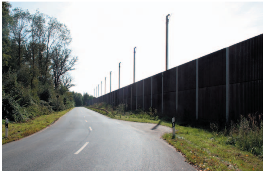
Lärmschutzwände mit Berieselungsanlagen sollen die anliegenden Siedlungen vor Emissionen schützen. (Foto: T. Knüvener)
