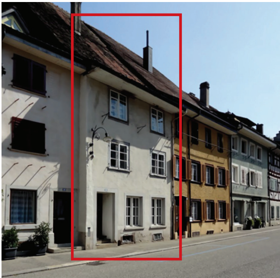
Abb. 7-8. Haus an der Vorgasse 44, Hauptfassade (links) und Rückfassade zur Mühlgasse. Fotos: Autorin.
