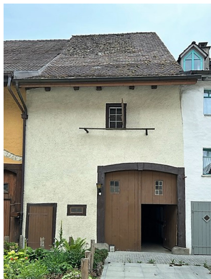
Abb. 15. Rückfassade zur Mühlen-gasse. Foto: Autorin.
