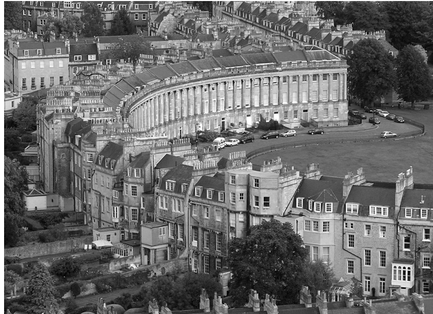
Abb. 25: Formstrenge Vorderfassade, informelle Rückseite, Beispiel Royal Crescent in Bath. Wikimedia Commons.
