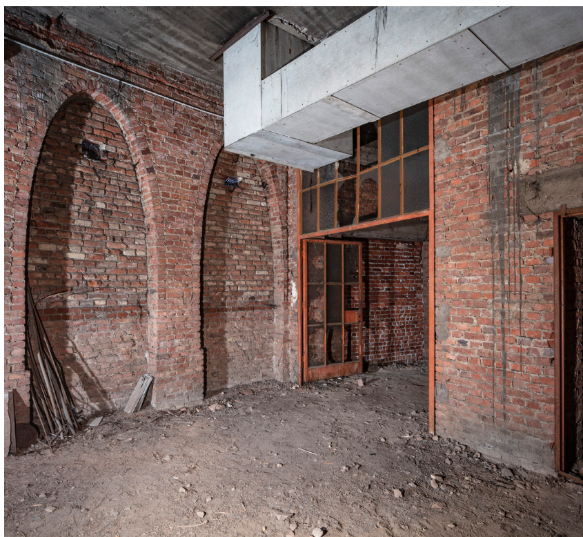
Abb. 6–7 Der zentral angelegte Pfarrsaal im Untergeschoss wurde durch einen Estrichboden nutzbar gemacht, eine zwischenzeitlich projektierte Behandlung der Oberflächen blieb ohne Ausführung. Die Räume des östlichen Jugendheimes blieben als Rohbau der ersten Bauphase erhalten. Als die Entscheidung getroffen war, diese Räume nicht zu nutzen, wurden die Fensteröffnungen mit Ziegelmauerwerk verschlossen. Fotos: © Reinhard Görner, Berlin
