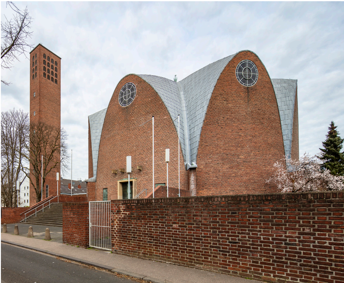
Abb. 1 Der Baukörper von St. Engelbert bildet mit den Gewölbekappen der Betonschalen die Form des Innenraumes außen ab. Foto: © Reinhard Görner, Berlin
