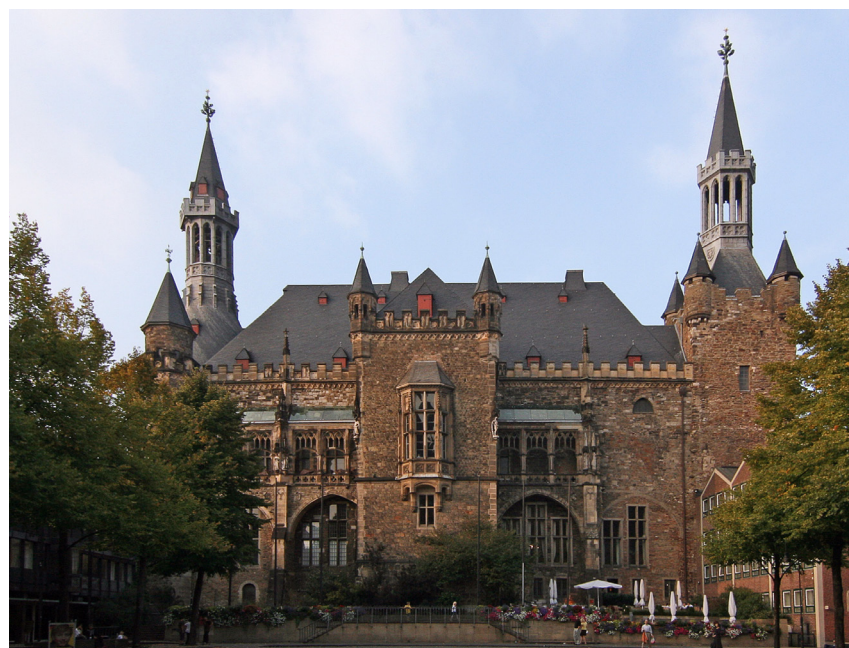
Abb. 1. Die Ansicht des Rathauses vom Katschhof. In der Mitte des Gebäudes ist das Ark'sche Treppenhaus (1840) zu sehen. Der Granusturm auf der rechten Seite entstammt bis in die oberen Mauerzonen der karolingischen Pfalzanlage. Foto: Roswitha Eichberg, https://commons.wikimedia.org/wiki/File:Aachen_Katschhof_mit_Rathaus.jpg (aufgerufen am 08.03.2018).
